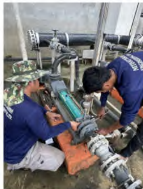
รูปภาพ การดำเนินงานซ่อมบำรุงรักษาเครื่องจักรกล ของระบบบำบัดน้ำเสียส่วนกลางนคร
